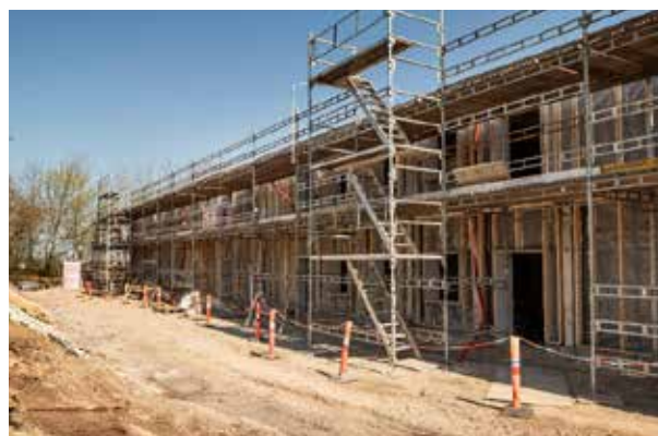
HAKI-stillads er stillet op Træskelet m. dampspærre er monteret.
