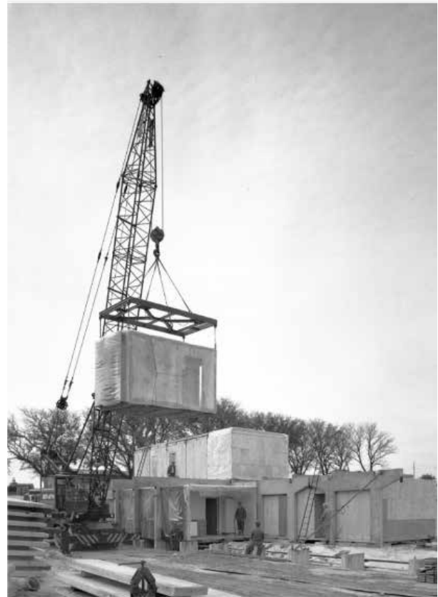
Montage af box-elementerne tilbage i 1965. Elementerne er pakket ind i plast for at beskytte mod vejrliget
